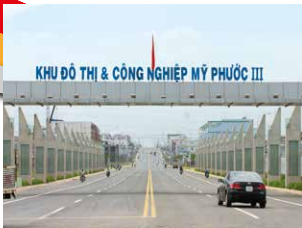
KHU CÔNG NGHIỆP MỸ PHƯỚC III
